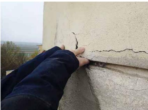
Es zeigte sich, dass zwischenzeitliche mehrfache überwiegend großflächige Putzreparaturen an den Fassadenflächen durchgeführt wurden, wobei ältere Reparaturen kalkgebunden waren, die jüngeren einen hydraulischen Bindemittelanteil aufzeigen bzw. am Turm auch
